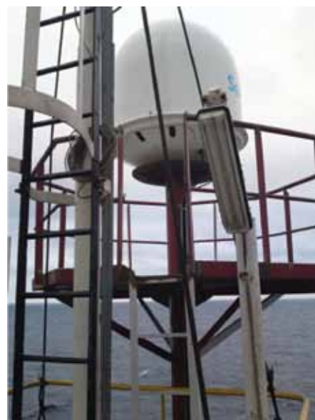
نصب و راه اندازی آنتن مارین
